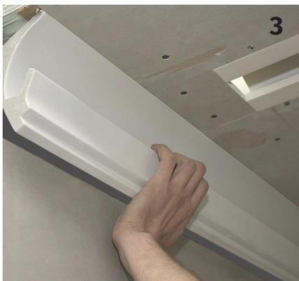
Unire i profili e fissarli con le viti alla struttura metallica.
