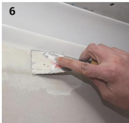
Stuccare in tre passate tutta la superficie del cartongesso. Alla seconda passata rivestire con la garza per giunti.
