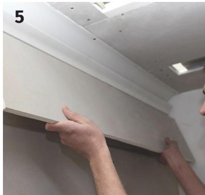
Coprire i battenti con il secondo pannello di cartongesso e fissare con le viti.
