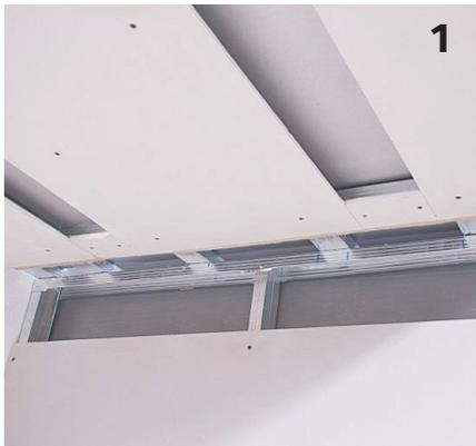
Applicare la colla sulla struttura metallica e sul profilo.
