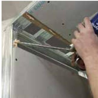
Applicare la colla sulla struttura metallica e sul profilo.
