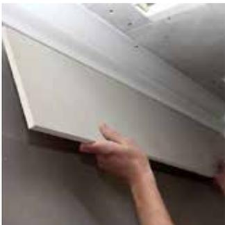
Coprire i battenti con il secondo pannello di cartongesso e fissare con le viti.
