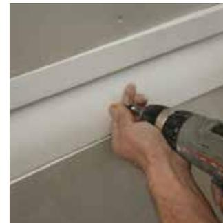
Unire i profili e fissarli con le viti alla struttura metallica.
