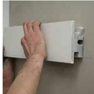
Posizionare con cura il profilo premendolo a muro.
