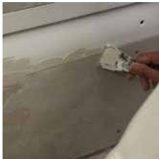
Stuccare in tre passate tutta la superficie del cartongesso. Alla seconda passata rivestire con la garza per giunti.
